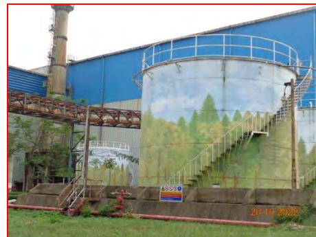
ภาพที่ 2-56 คันคอนกรีตรอบบริเวณถังน้ำมันและถังบรรจุสารเคมี
