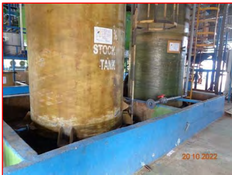
ภาพที่ 2-56 คันคอนกรีตรอบบริเวณถังน้ำมันและถังบรรจุสารเคมี
