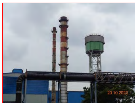
ภาพที่ 2-3 ปล่องระบายอากาศเสีย ของเตาเผาเหล็ก
